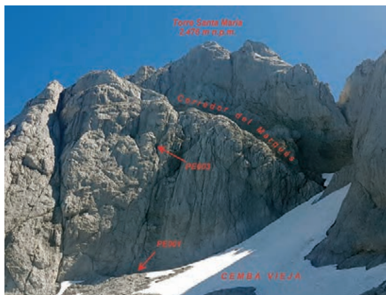
Północno-wschodnia ściana Torre Santa María
