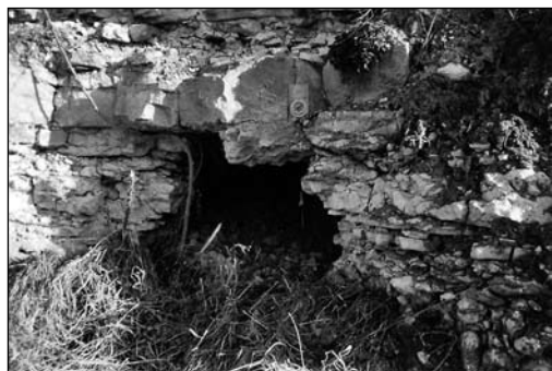
Otwór Schroniska nad Odrą
