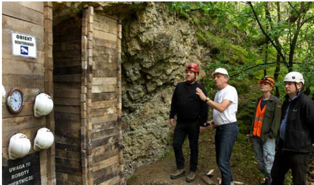
△ Niekończące się konsultacje naukowców i urzędników z inżynierami. Z lewej widoczne w głównym otworze tymczasowe kaszty podpierające strop, z prawej żelbetowy filar w trakcie budowy w Sali Puchacza • Fot. Jerzy Zygmunt
