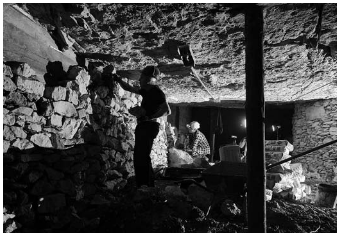
△ Górnicy obmurowują Filar Sarkofag wapiennymi blokami. Pod stropem widoczne ciężno, z prawej – fragment Słupa Podporowego w Sali Przejściowej • Fot. Jerzy Zygmunt 2016
