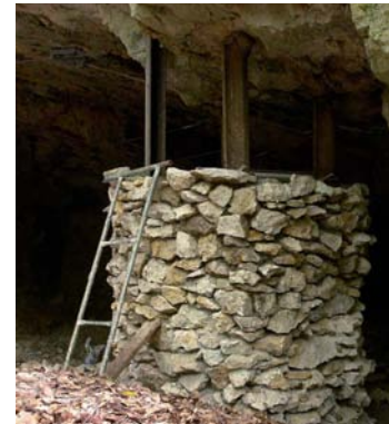
△ Niekończące się konsultacje naukowców i urzędników z inżynierami. Z lewej widoczne w głównym otworze tymczasowe kaszty podpierające strop, z prawej żelbetowy filar w trakcie budowy w Sali Puchacza • Fot. Jerzy Zygmunt
